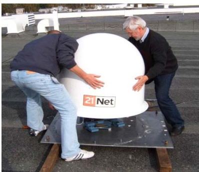
(그림 4) 21Net 80 cm 반사판 안테나 레이돔 장착
